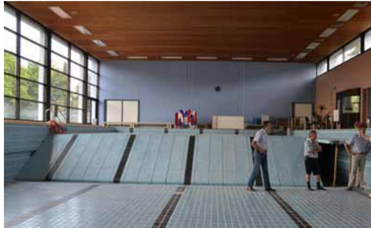
Jagdfeldbad wird renoviert
