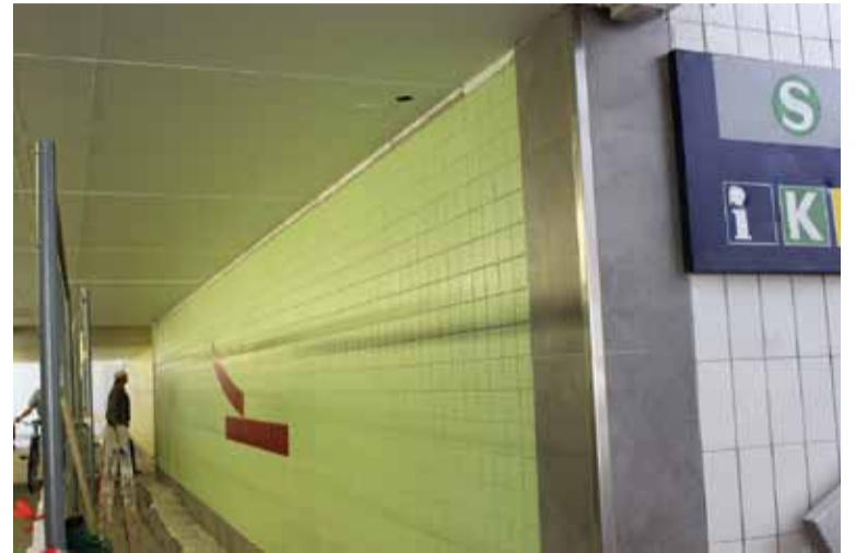
Blick in die neu gestaltete Unterführung
