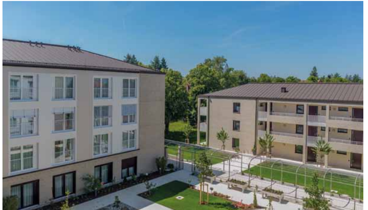
Blick in den Innenhof des neuen Pflegeheims über den Rosenlaubengang hin zum Wohnen mit Service
