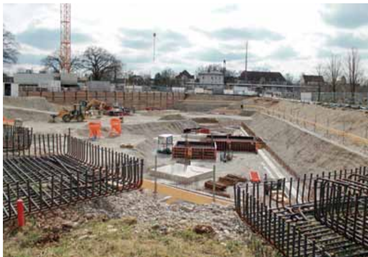
Die Baustelle der Firma Attocube am Haarer Dreieck. Noch ist nicht zu erkennen, welches modernes und attraktives Gebäude hier entstehen wird.
