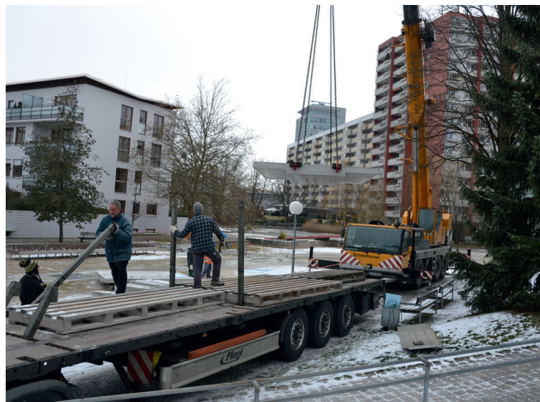
Die neue Brücke über den Jagdfeldsee wird gebaut. Beton und Stahl der alten Brücke waren so angegriffen, dass eine Sanierung nicht mehr möglich war.
