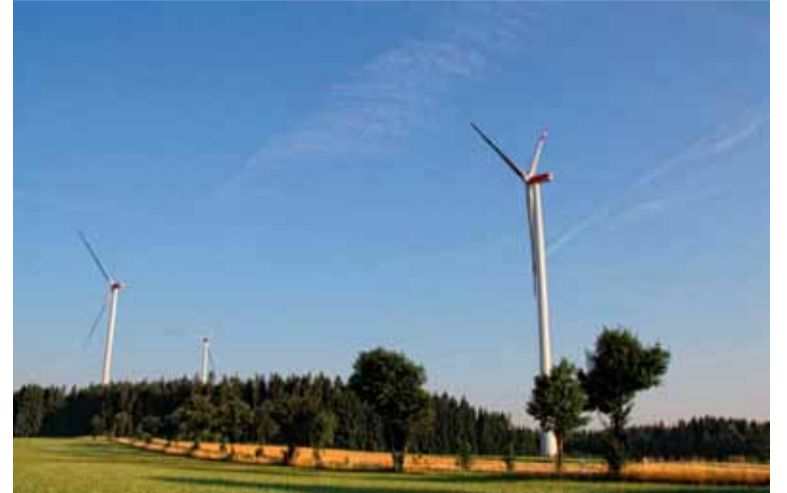
Windräder im Windpark Schauenstein in Oberfranken
