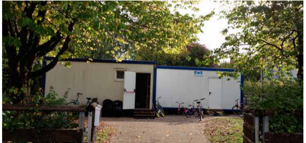
Bisherige Unterkunft für 14 Asylbewerber. Die Container am Fasanenweg dienten ursprünglich der provisorischen Unterbringung des evangelischen Kindergartens während des Umbaus.
