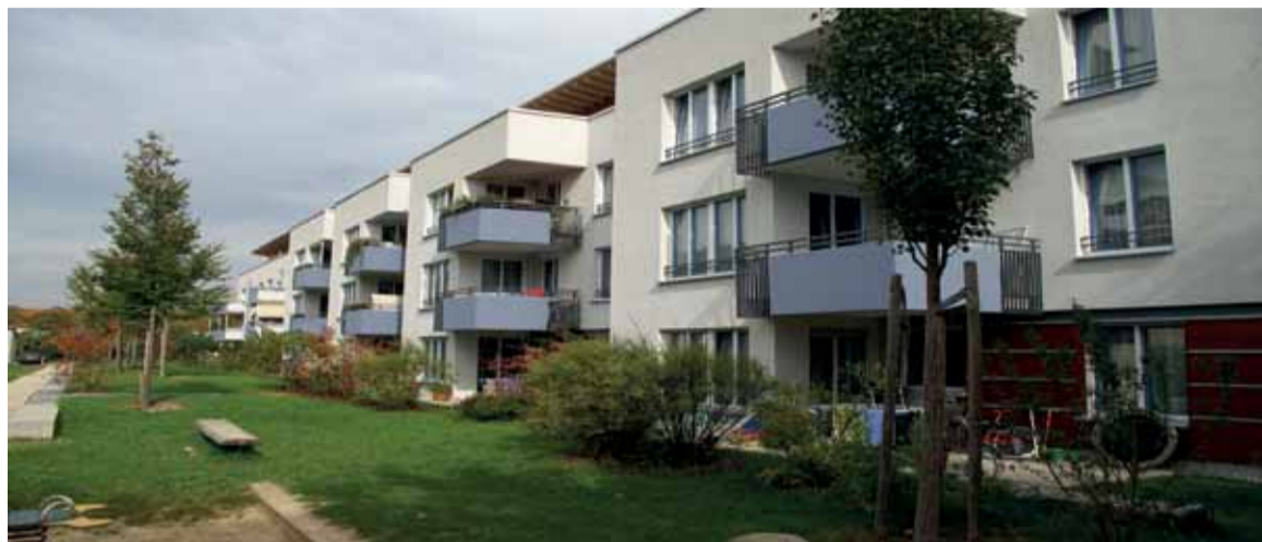
Unser letzter kommunaler Wohnungsbau in der Keferloher Straße
